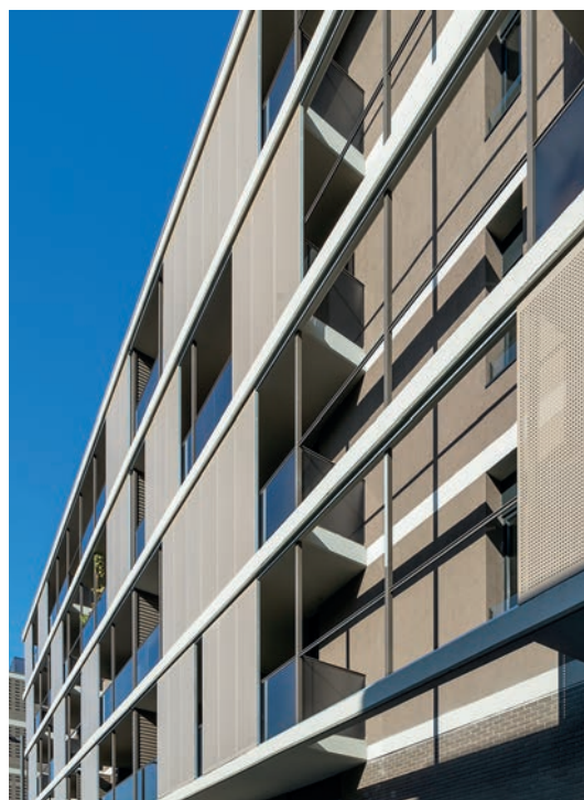
Edificio plurifamiliar Rambla Marina, Barcelona Arquitectos: Ribas & Ribas Arquitectos y Plasencia Arquitectura Foto: © Juan Rodríguez
