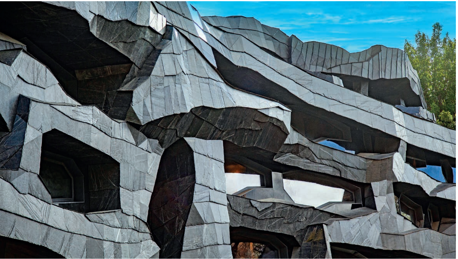
La Querola de Ordino, Andorre. Architectes : Ateliers Jean Nouvel, Ribas & Ribas Arquitectos et Jordi Sala. Photo: © Pepo Vázquez
