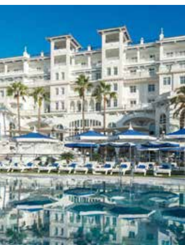
Gran Hotel Miramar (Málaga)
